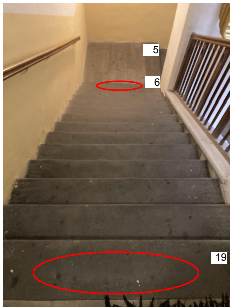
PROŠLAPÁNÍ VÝSTUPNÍCH A NÁSTUPNÍCH SCHODIŠŤOVÝCH STUPŇŮ + UŠTÍPNUTÍ STUPNIC - VÝMĚNA VIZ. POZNÁMKA
