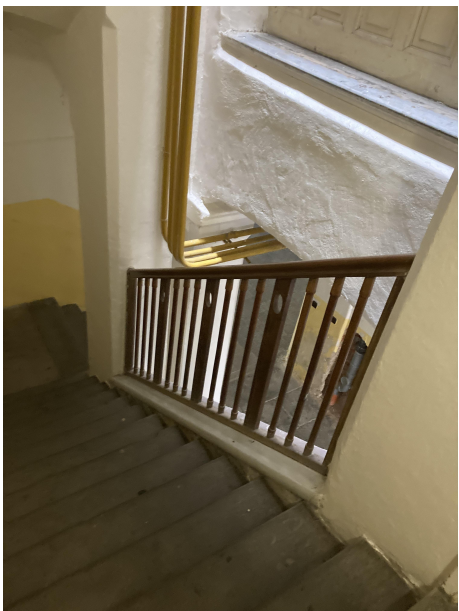
ZÁBRADLÍ A MADLO BUDE DEMONTOVÁNO, NOVĚ OPRÁVENO A NAMONTOVÁNO ZPĚT
